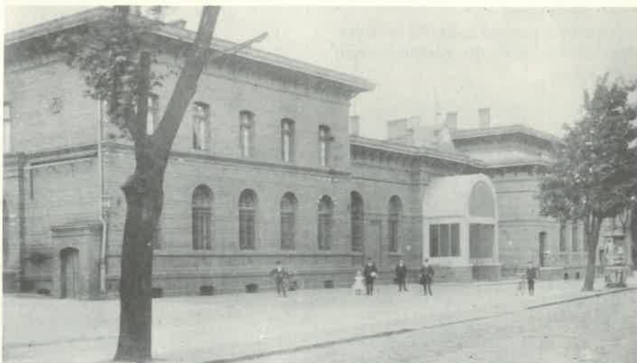
Das zweite Luckenwalder Bahnhofsgebäude stand gegenüber der jetzigen „Apotheke am Bahnhof“ und dem Wohnblock Bahnhofstraße 2 - 4.
